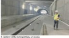
Il cantiere della metropolitana a Catania
