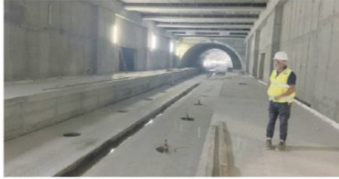
Il cantiere della metropolitana a Catania
